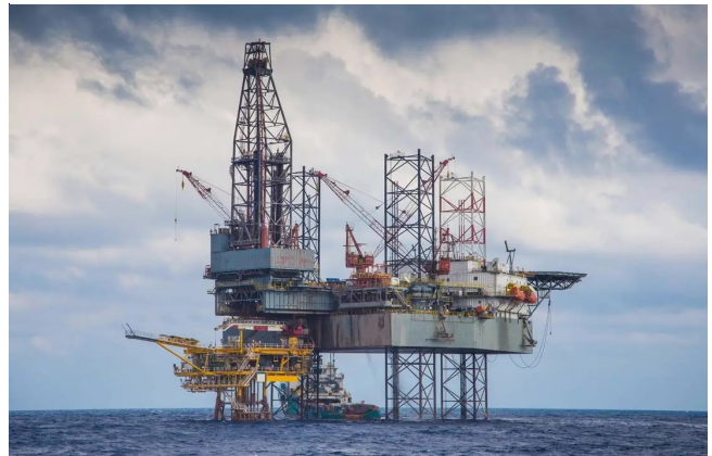
海上钻井平台及油田井架等场所
