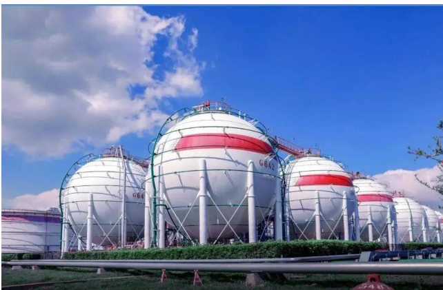
油库及化工罐区
