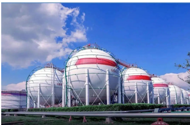
油库及化工罐区
