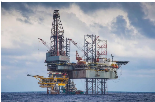
海上钻井平台及油田井架等场所
