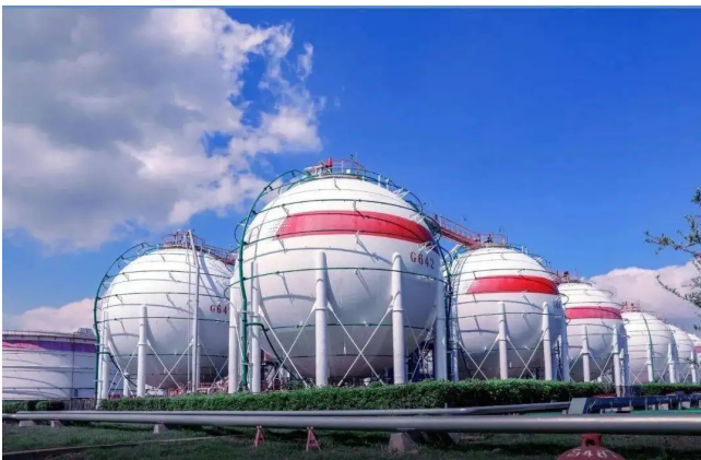
油库及化工罐区
