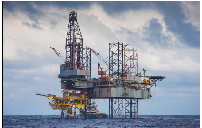
海上钻井平台及油田井架等场所
